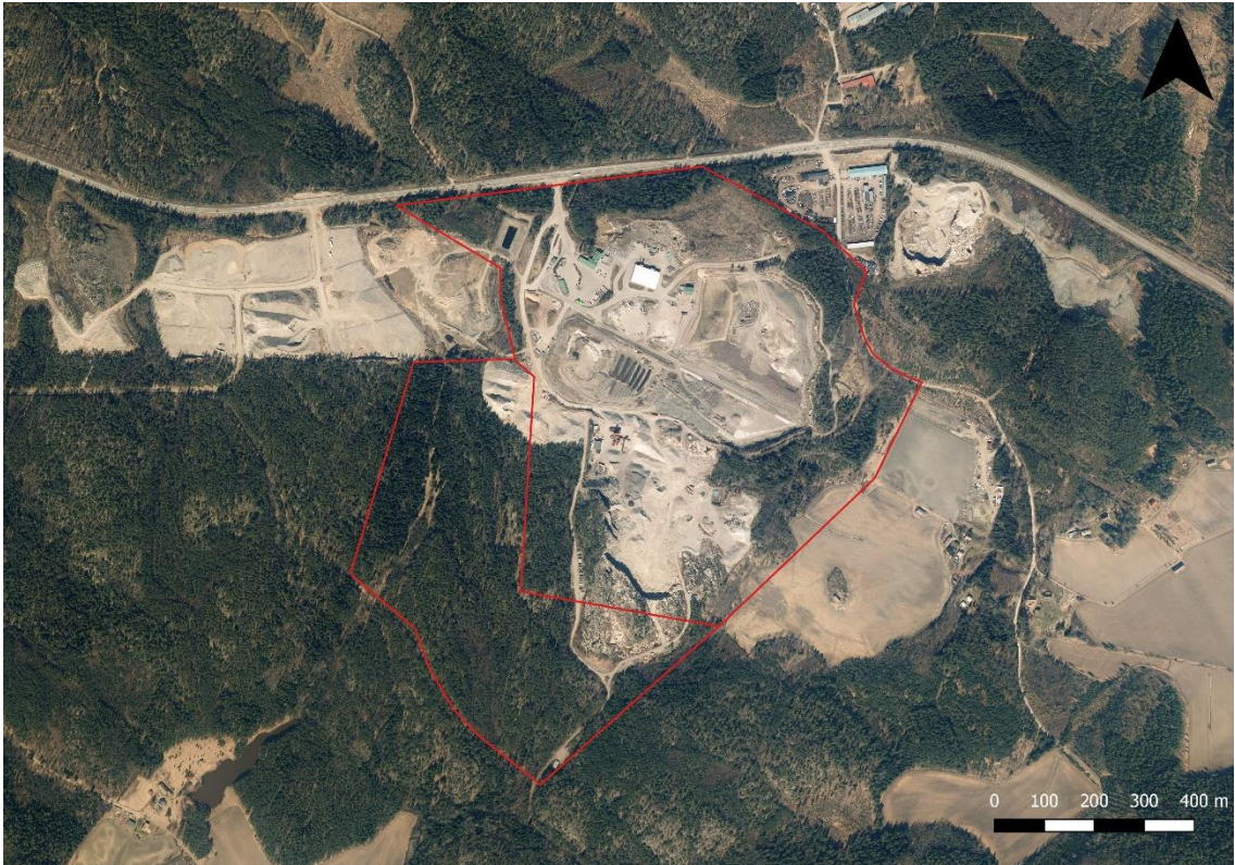
Kuva 2-1. Ilmakuva Korvenmäen jätekeskuksen alueesta (Ilmakuva: Maanmittauslaitos). Kartassa on esitetty punaisella viivalla tässä lupahakemuksessa käsitelty hankealue sekä YVA:ssa käsitelty hankealue, joka sisältää myös jätekeskuksen lounaispuolella olevan alueen.
