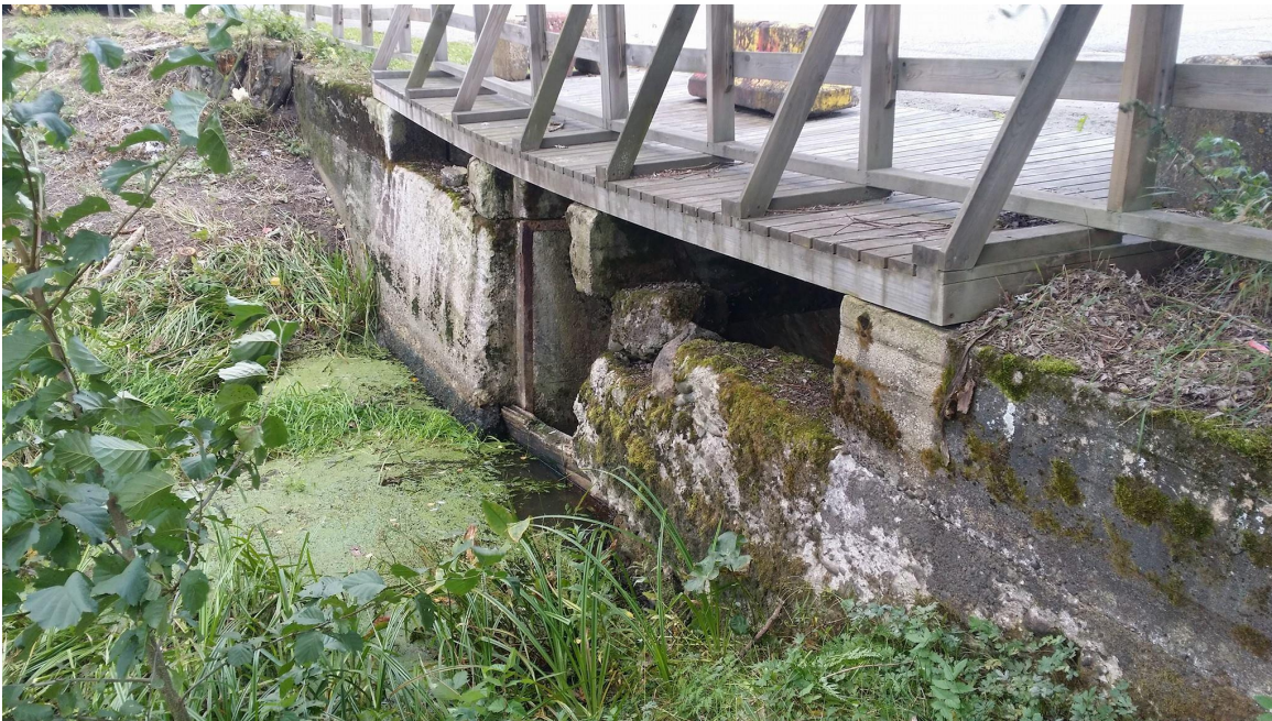
Kuva 10: Padon aukon päälle rakennettu väliaikainen laitur.
