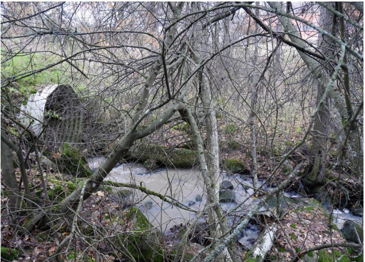
SKDG201906:10 Kiveyksen läpi on kaivettu putki, josta vesi nykyään virtaa. Putken edessä näkyy nähtävästi padosta irrotettuja kivipaasia.
