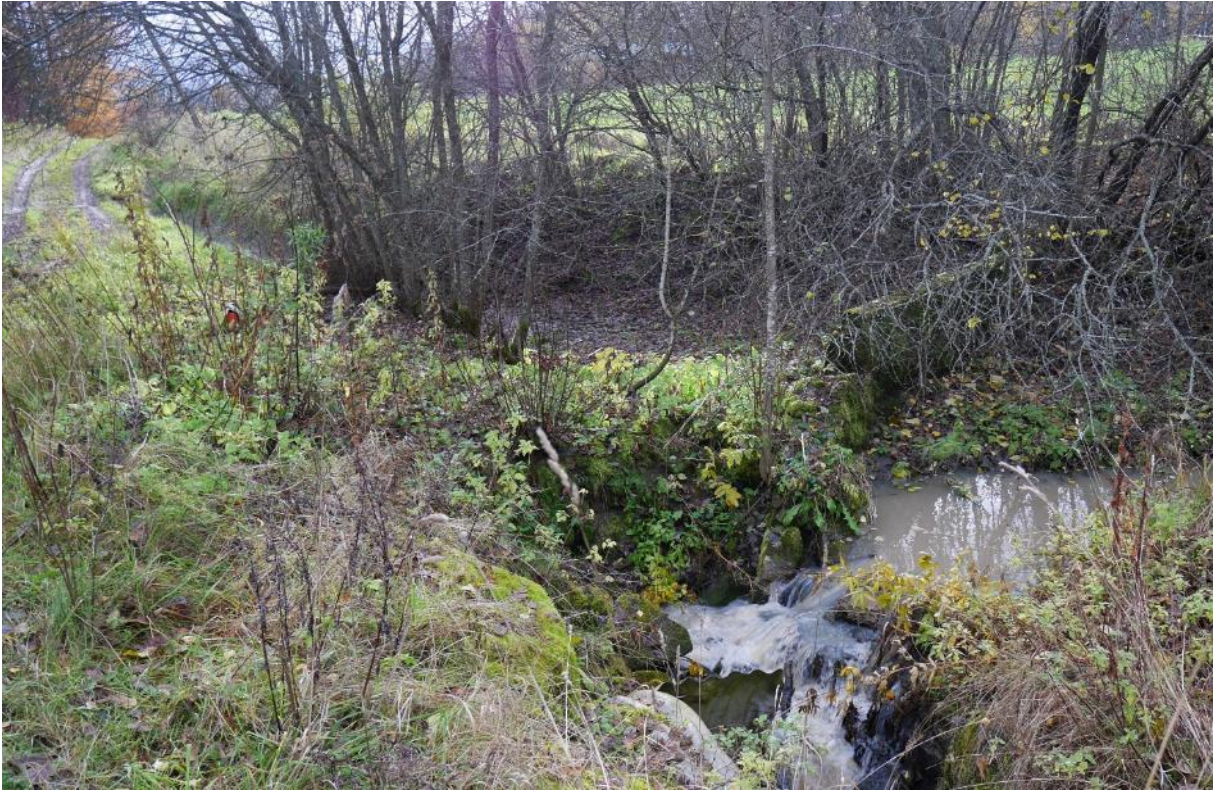
SKDG201906:9 Isojakokartan mukaan vanhempi eteläinen pato näyttäisi olleen tämän kylämäelle johtavan tien alla, oikealla näkyy myös uudempaa betonista seinämää.
