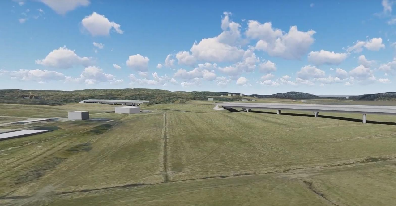
Kuva 12. Pysäytyskuva Sammalonsalmen peltoalueen kohdalta yleissuunnittelun yhteydessä tehdystä Hirsijärvi, Salo -videosta ( https://vayla.fi/kaikki-hankkeet/espoo-salo-oikorata/ ). Pysäytyskuvassa näkymä kaakosta oikoradalle. Oikealla on peltoalueen ylittävä silta ja vasemmalla kauempana Hirsijärven ylittävä silta, jonka jälkeen rata sukeltaa tunneliin.
