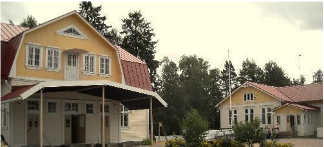
Kuva 5. Hajalan koulu ja päiväkoti.
