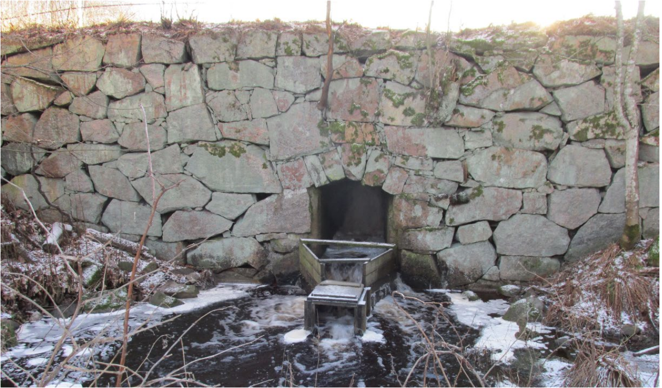
Kuva 5. Hamarijärven (Munamäen) pato alapuolelta kuvattuna. Kuvassa väliaikainen nahkiaisten laskemiseen käytetty väliaikainen rakenne, joka poistetaan myöhemmin. Kuva Pekka Leiviskä 6.2.2020.
