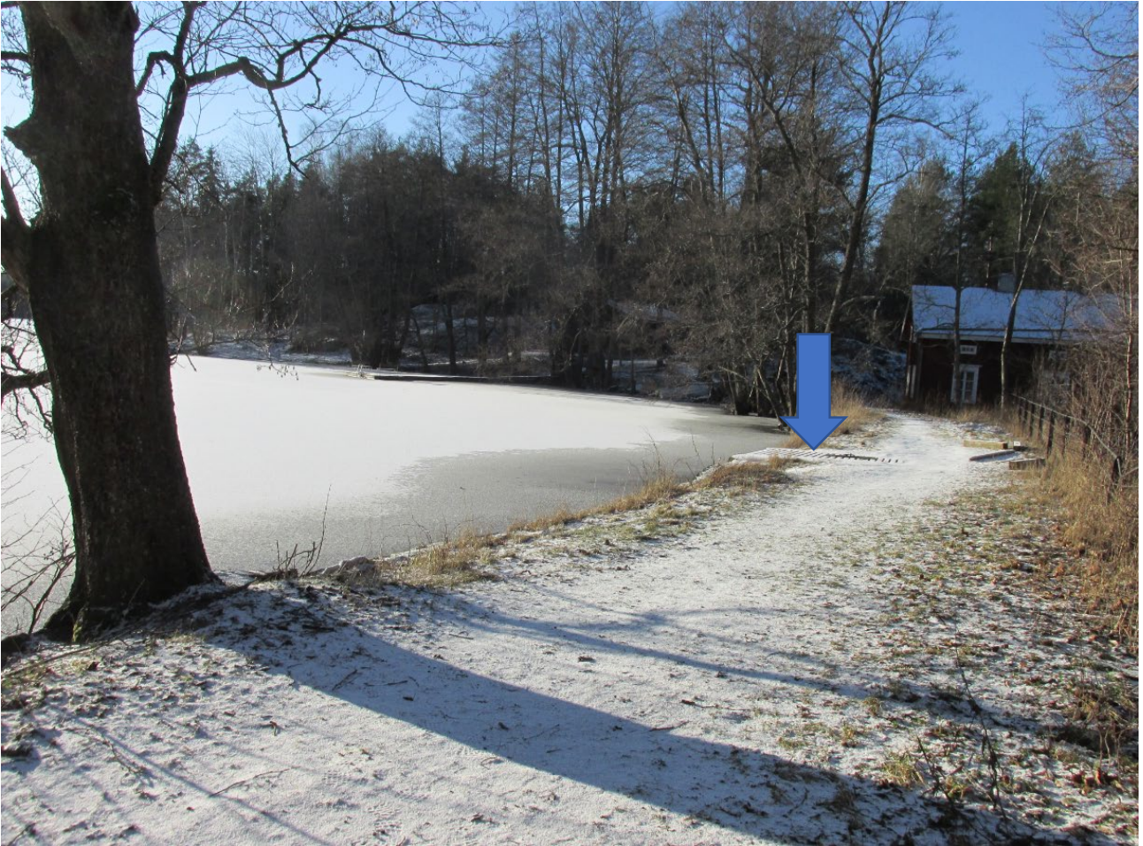
Kuva 3. Hamarijärven padon harja, säännöstelyrakenne padon keskiosassa. Kuva Pekka Leiviskä 6.2.2020.
