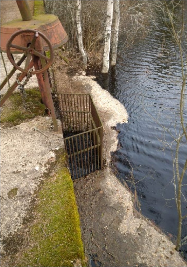
Kuva 7. Putimenlahden säännöstelypato. Kuva Pekka Leiviskä 26.2.2020.
