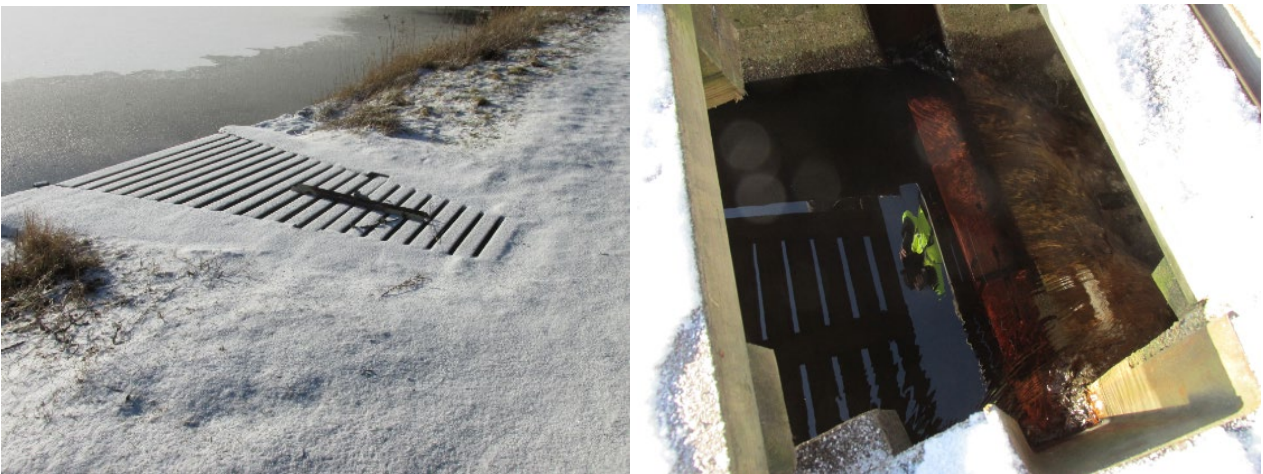
Kuva 4. Hamarijärven padon säännöstelyrakenteen kansi ja settiurat kansi avattuna. Kuvat Pekka Leiviskä 6.2.2020.
